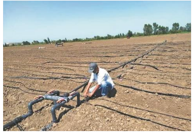
الشكل (5): مكونات شبكة الري بالتنقيط
